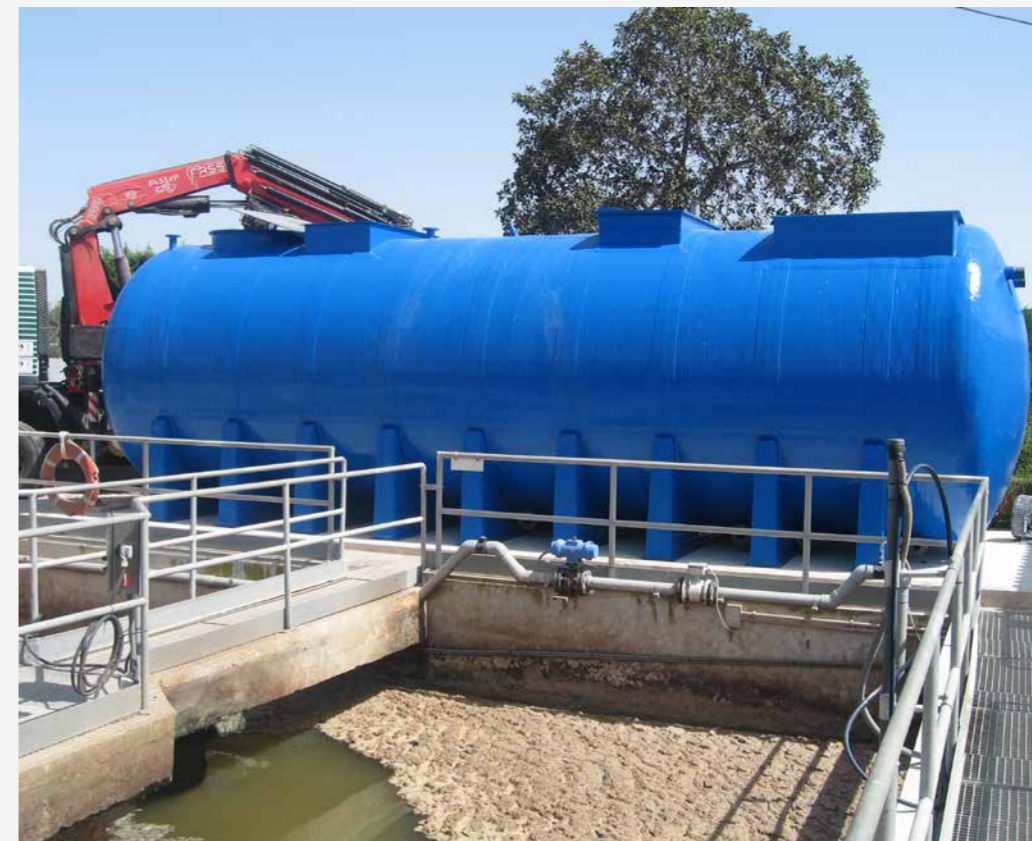
Oxidación total desnitrificación
